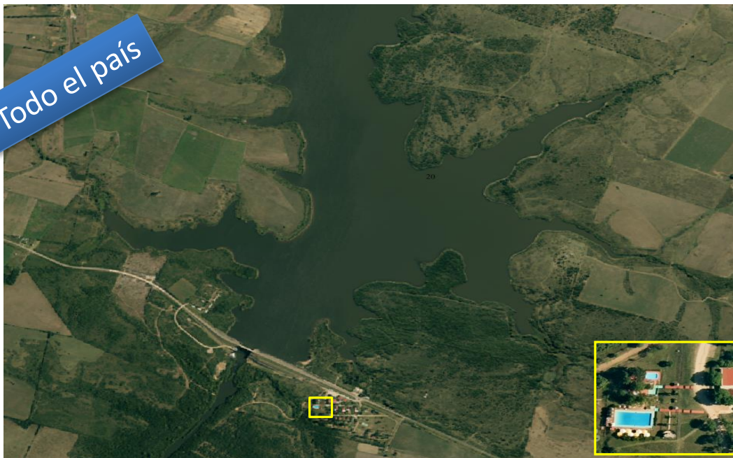
Represa de Paso Severino
